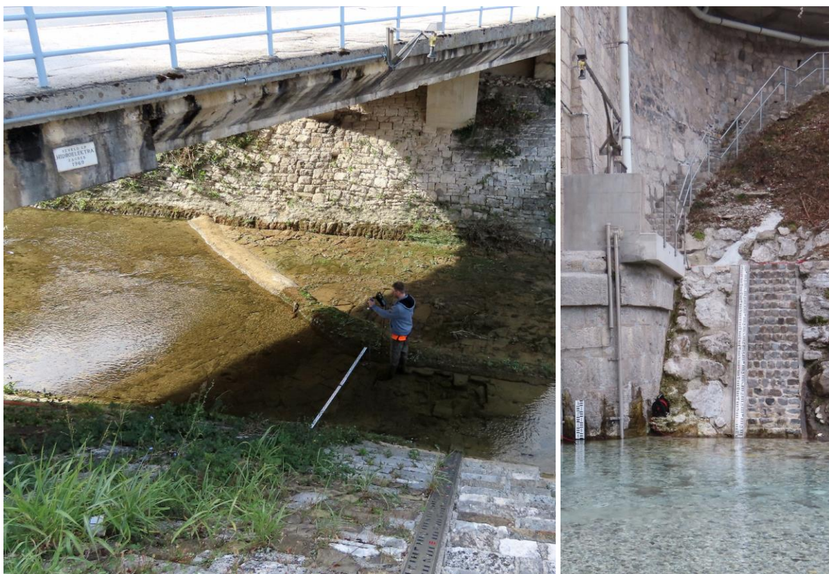
Slika 2.2: Obnovljeni usmerjevalni prag na merilnem mestu Podkaštel I na reki Dragonji – levo, in merilna postaja Tolmin I na reki Tolminki – desno (foto: arhiv ARSO)
