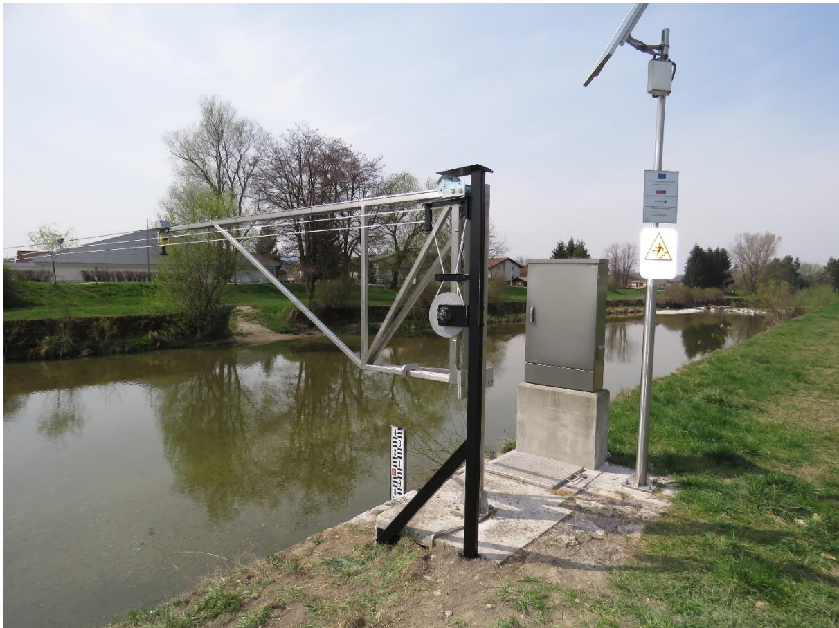
Slika 2: Začasna vrvna premostitev za izvajanje meritev pretoka visokih voda na Viru na Kamniški Bistrici (foto: Primož Gajser)
