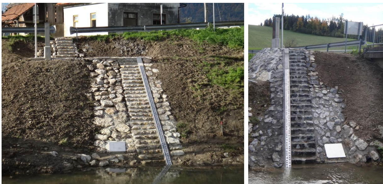
Slika 4: Izvedba novih avtomatskih merilnih mest na v. p. Rečica na Paki (slika levo) in na v. p. Gaberke na Velunji (slika desno) (foto: Marko Burger)
