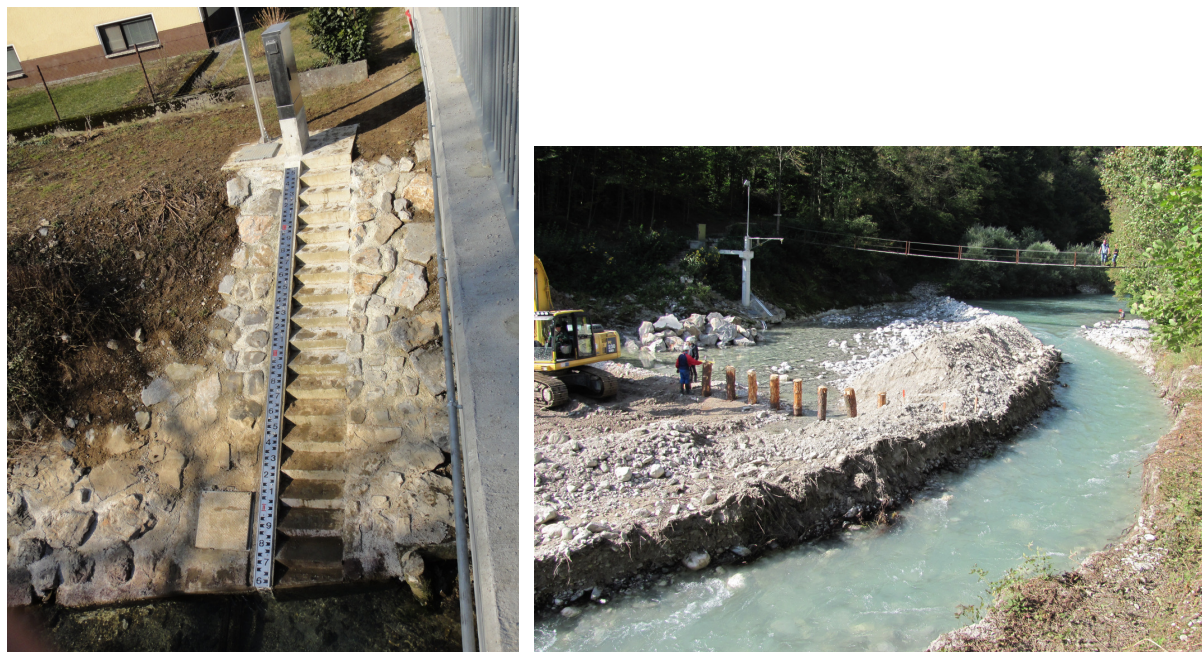
Slika 3: Izvedba gradbenih del na v.p. Dvor (leva slika) in v.p. Potoki (desna slika) (foto: Marko Burger)
