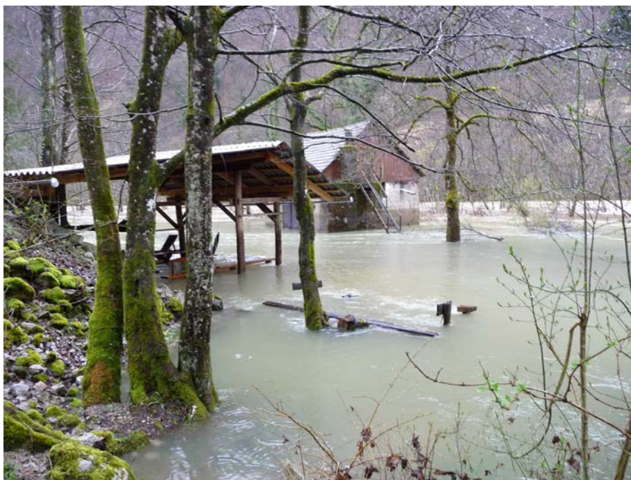
Slika 5: Ogroženost rekreacijskih površin in pripadajočih objekta v dolini Kolpe (foto: Mojca Sušnik)
