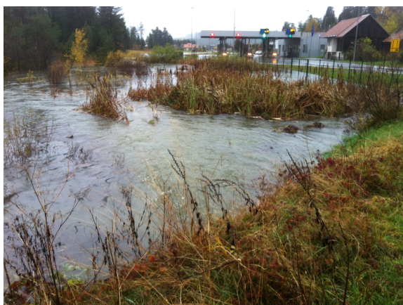
Slika 16: Med 6. do 8. novembrom je bil mejni prehod nad Babnim poljem delno zaprt. Voda je v tem času poplavljalja cesto in posamezne objekte v Bukovici na Babnem polju (foto: krajan Prezid-a) ).
