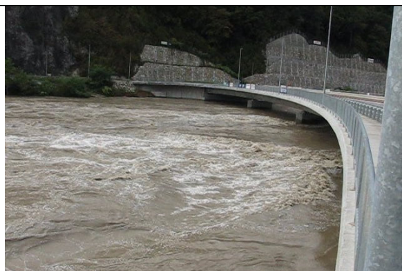
Slika 11: Zožan prečni profil na Savi (dolvodno od gradbišča nove HE Krško) povzroči prehiter in preveč valovit tok, kar onemogoča uspešno izvedbo meritve (foto: M. Burger)
