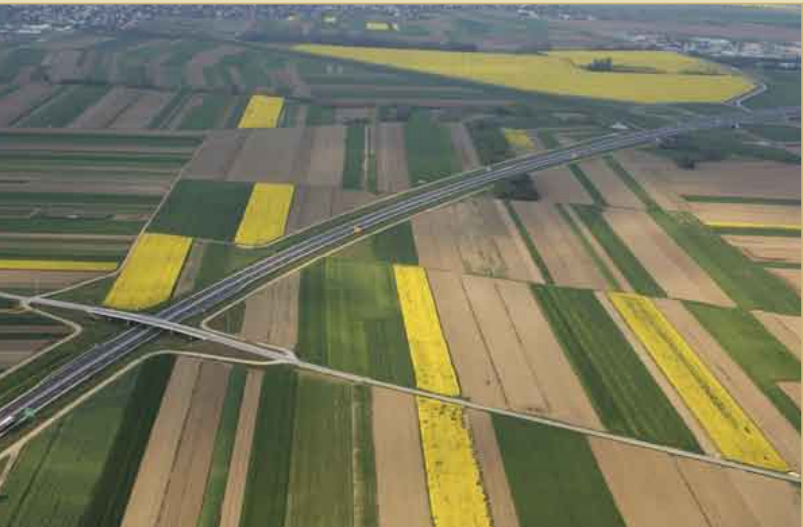
Avtocesta Murska sobota–Vučja vas–Rakičan, Matevž Lenarčič
