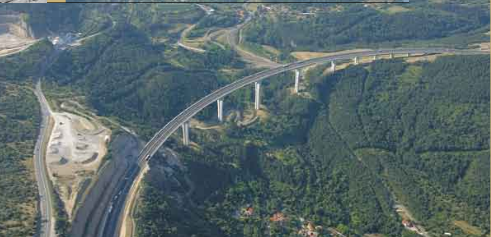
Viadukt na Črnem Kalu, Matevž Lenarčič
