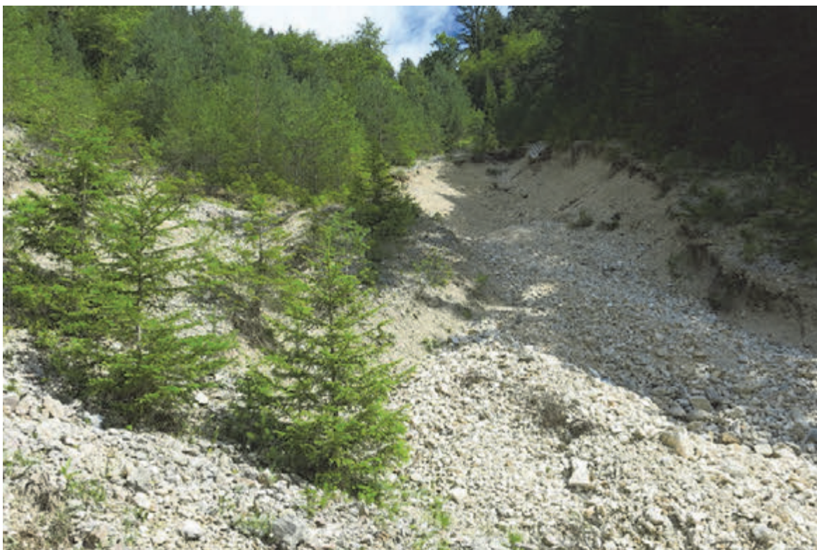
Slika 13: Globoki erozijski kanali na brežini
