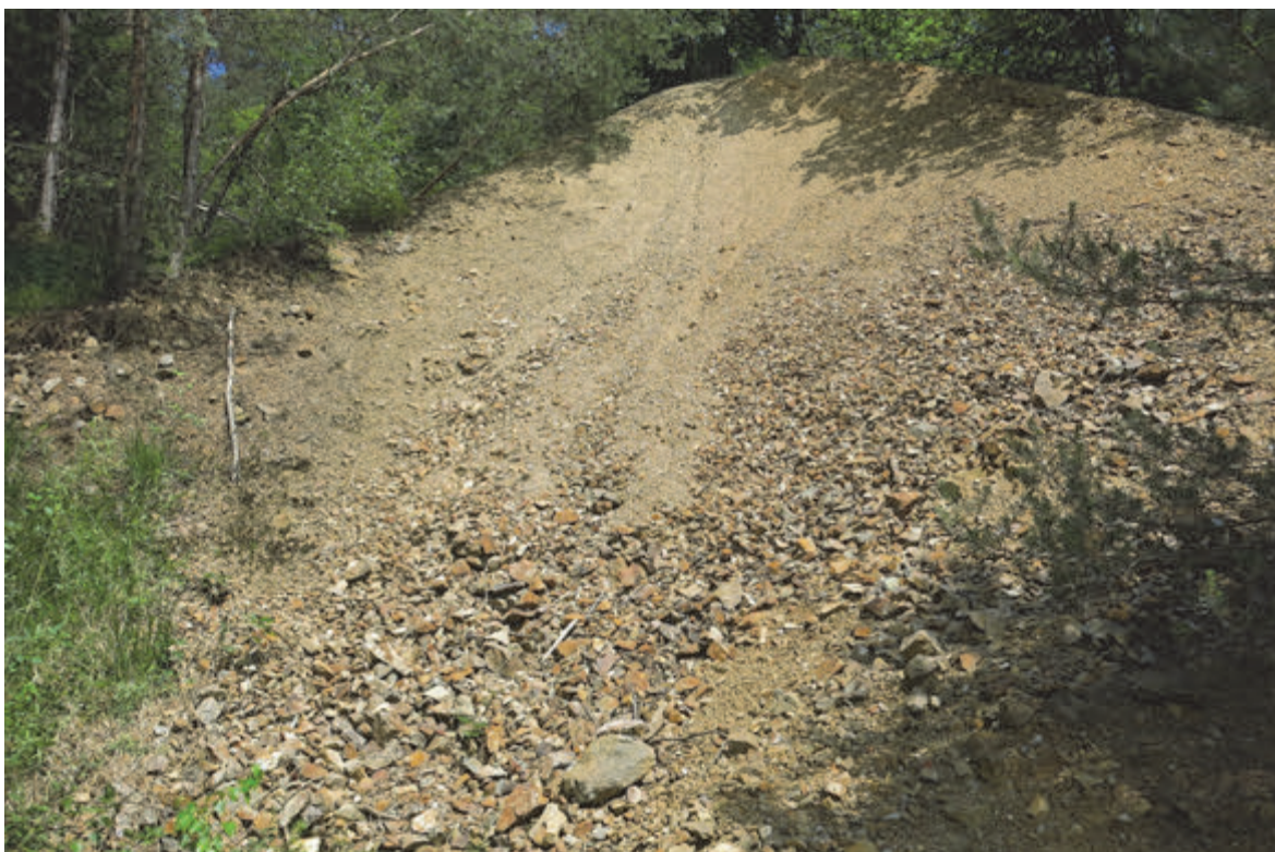
Slika 39: Erozijski podvržena brežina odlagališča 304 (E)
