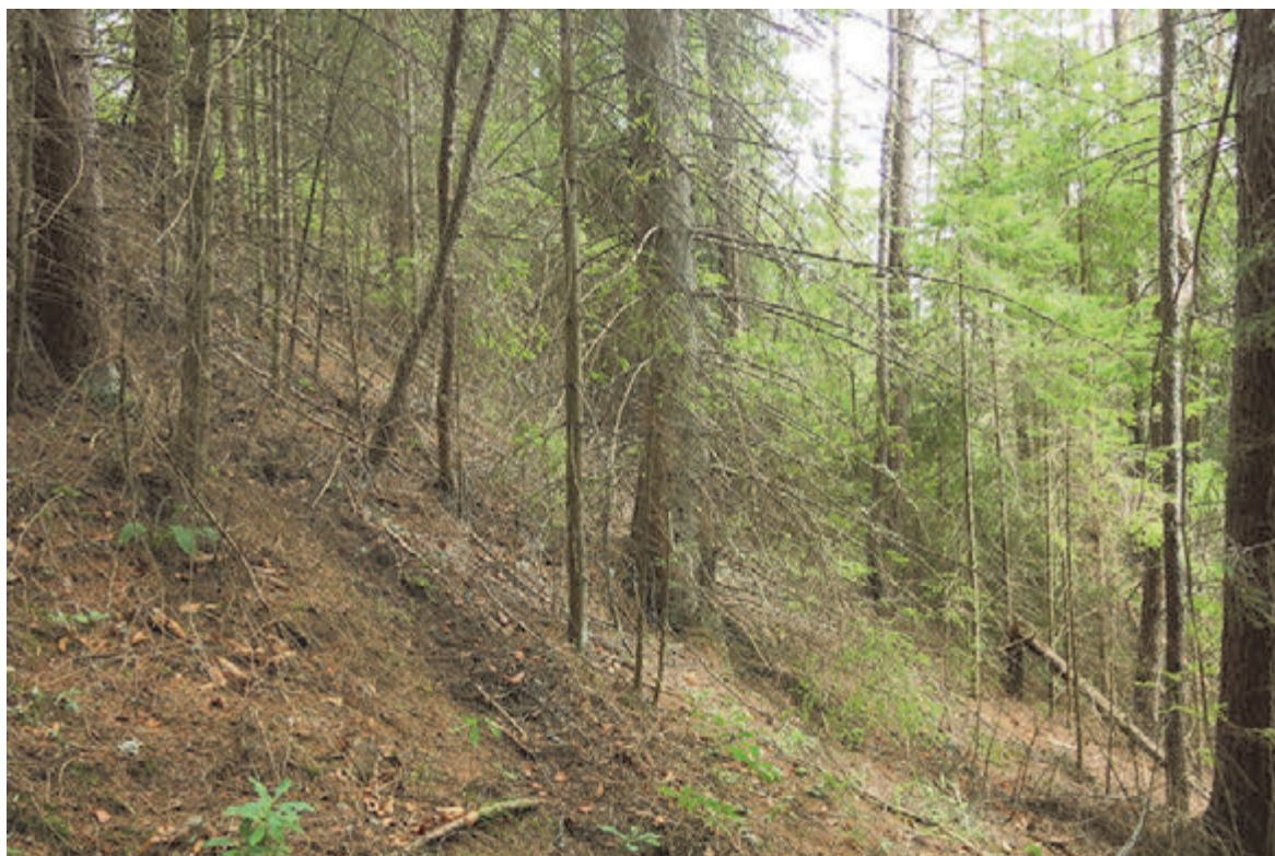
Slika 4: Stabilna brežina odlagališča K-26/1, porasla z gozdom.
