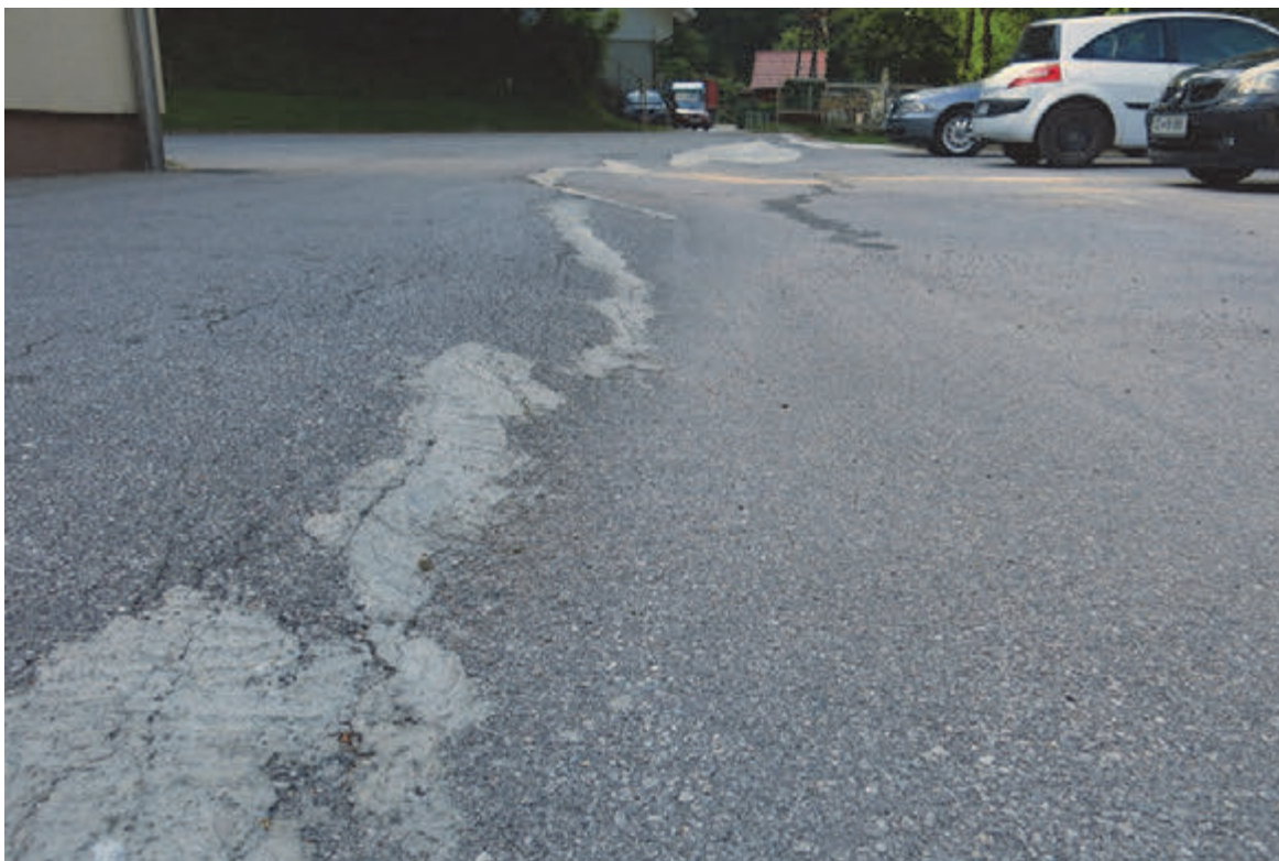
Slika 1: Deformacije platoja odlagališča pred objektom Inoxa.
