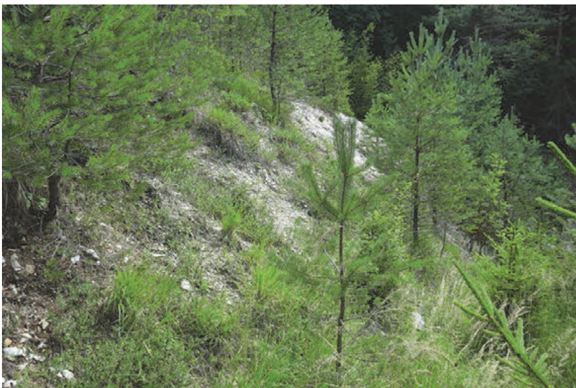
Slika 12: Stabilna brežina tik pod platojem, delno poraščena z borovci in smrekami
