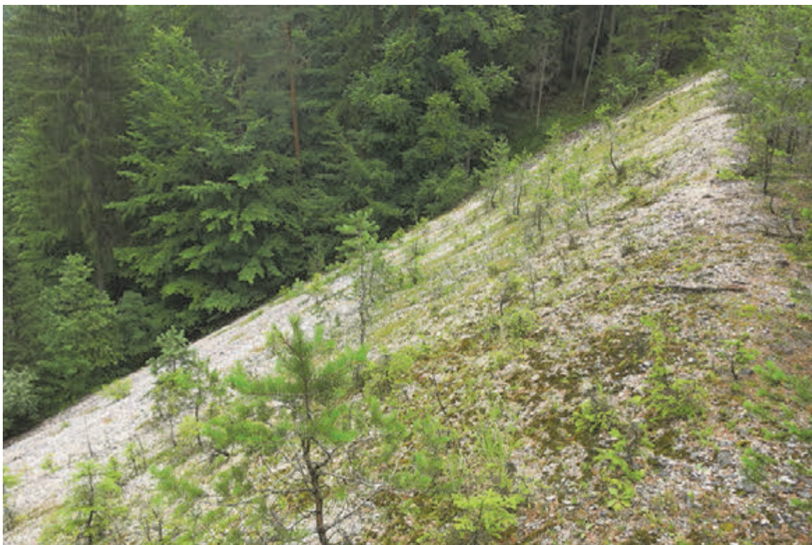
Slika 28: Brežina zahodnega dela odlagališča K-26/28
