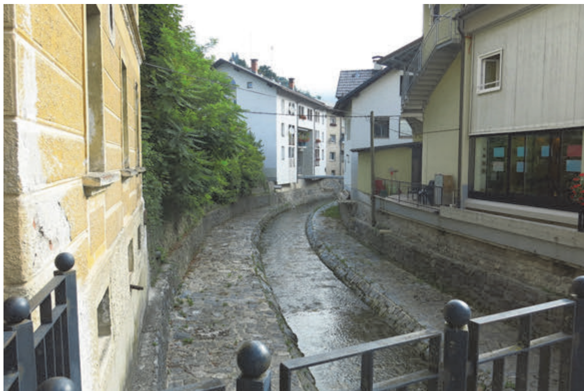
Slika 50: Struga potoka je utrjena s kamnom in betonom
