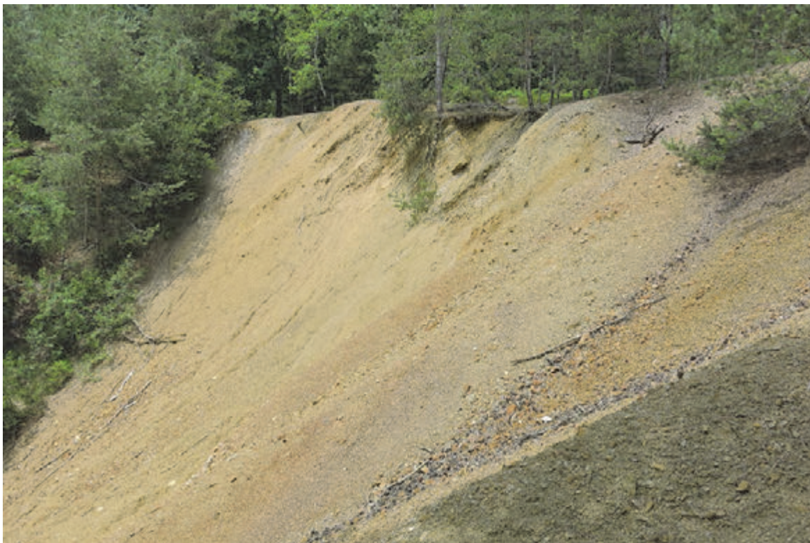
Slika 40: Strma, razkrita brežina odlagališča K-25/26
