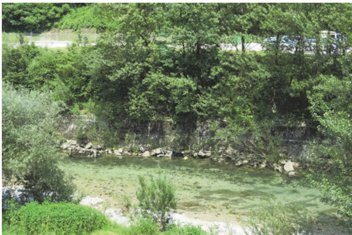
Slika 63: Zahodni rob odlagališča ob Idrijci je zavarovan z betonskim zidom
