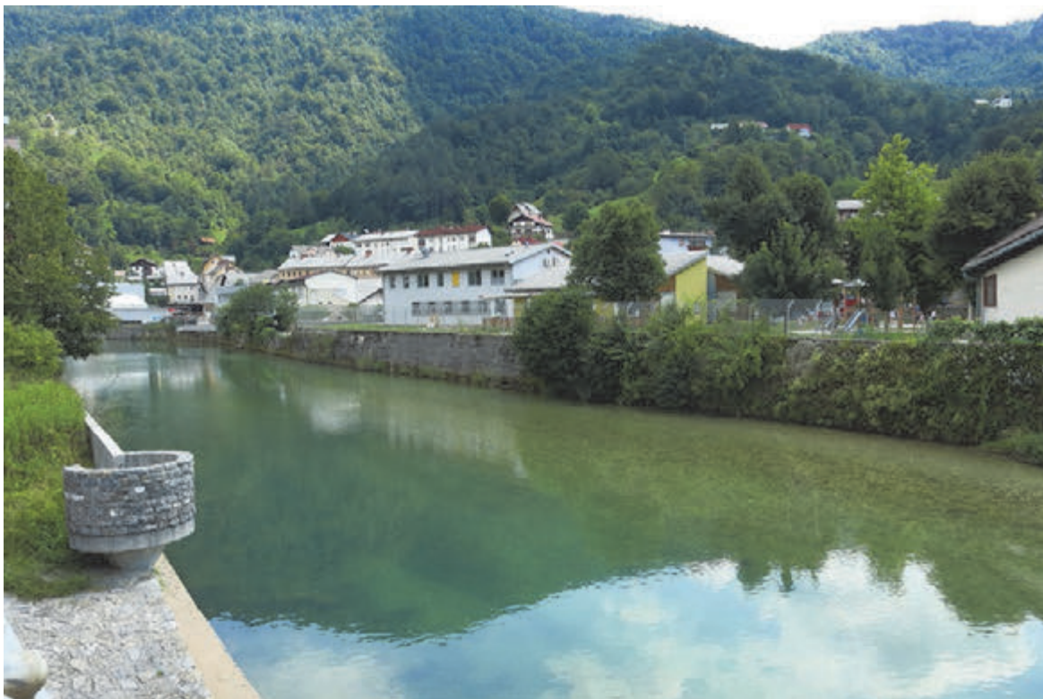
Slika 58: Zahodni rob odlagališča K-8/10 je ob Idrijci zavarovan z betonsko kamnitim zidom.
