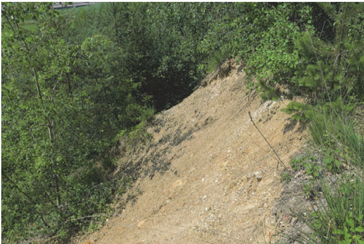
Slika 37: Strma, razkrita brežina v zgornjem delu z intenzivnejšo erozijo
