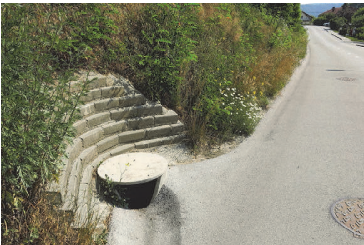
Slika 36: Urejeno odvodnjavanje v peti odlagališča Podsitarjevec
