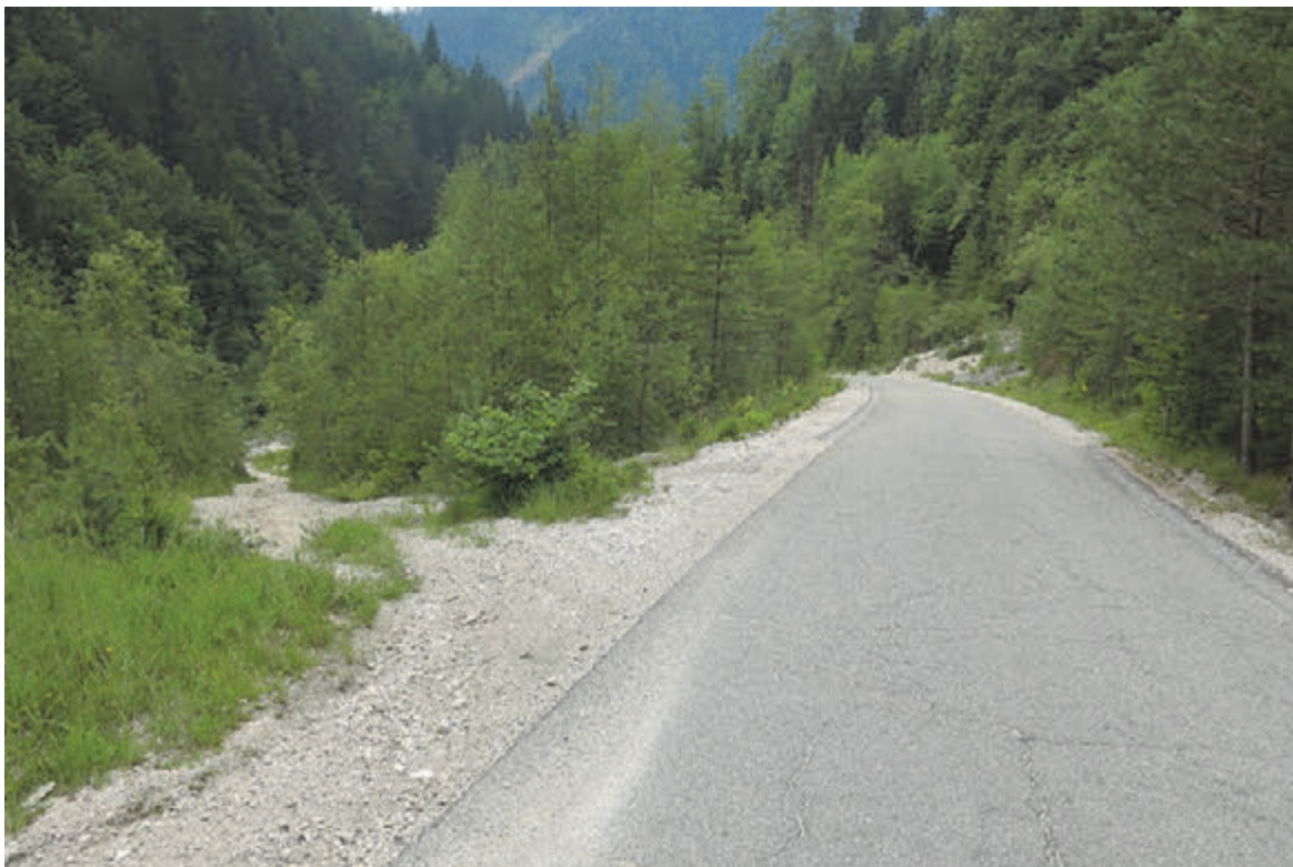
Slika 9: Pogled na odlagališče K-26/13 Helena
