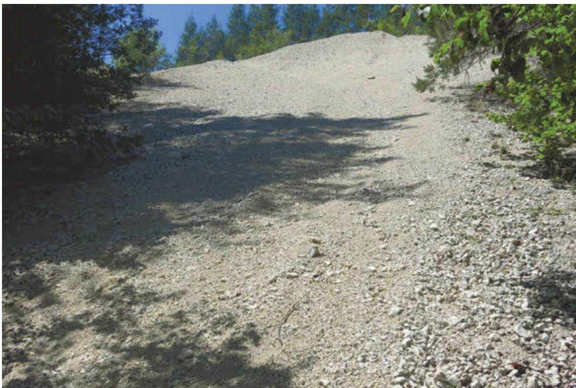
Slika 23: Nezaščitena brežina na vzhodnem robu odlagališča K-26/23
