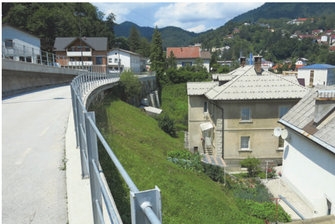
Slika 54: Stabilna brežina ob Prešernovi cesti
