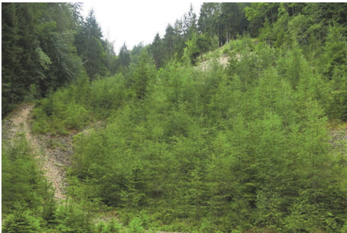
Slika 26: Vzhodni del: brežina zgornjega dela je poraščena z drevjem in stabilna
