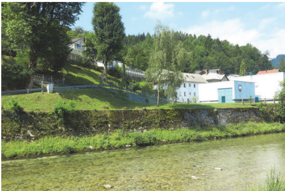
Slika 53: Zaščitená betonsko kamnita brežina ob Idrijci
