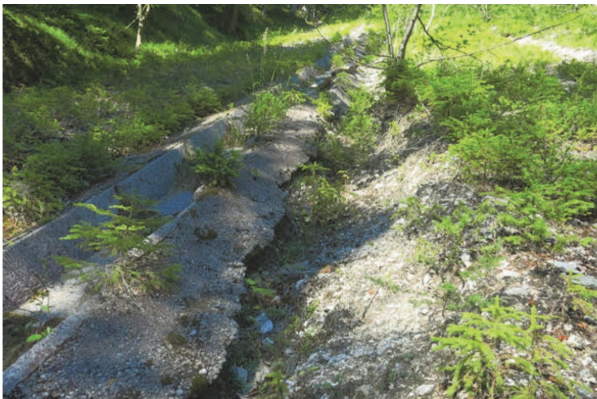
Slika 7: Spiranje materiala ob stranskih vzdolžnih kanaletah
