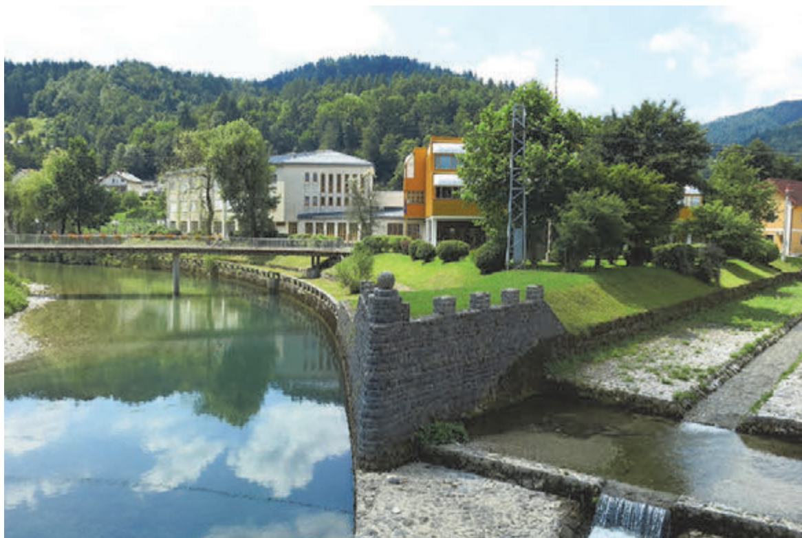
Slika 52: Levi pritok Idrijce pri Oš Idrija je zaščiten s kamnom in betonom.
