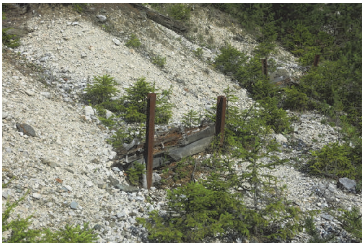
Slika 8: Preperel in polomljen les za železniškimi tračnicami
