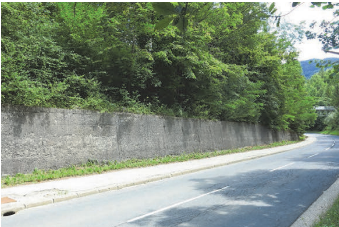
Slika 30: Z betonskim zidom zavarovana brežina ob cesti Mežica – Črna na Koroškem
