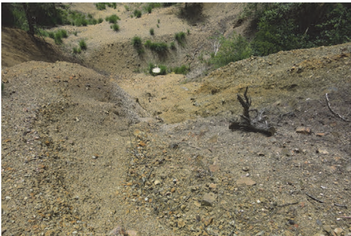
Slika 41: Erodirana brežina z jaškom za odvodnjavanje na odlagališču Grolovega rova K-25/26
