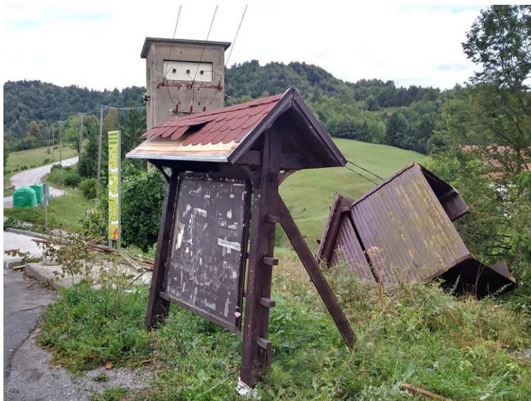
Slika 24. Po višku poletne vročine so nevihte ponekod povzročile kar nekaj škode. Zaplana, 17. avgust 2021 (foto: Martin Gustinčič) Figure 24. After the peak of summer heat, storms caused quite a bit of damage. Zaplana, 17 August 2021 (Photo: Martin Gustinčič)
