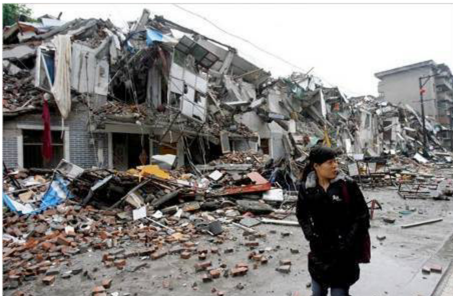
Slika 3. Na območju Sečuana se je porušilo več kot 5 milijonov objektov Figure 3. An estimated 5 million buildings collapsed in Sichuan
