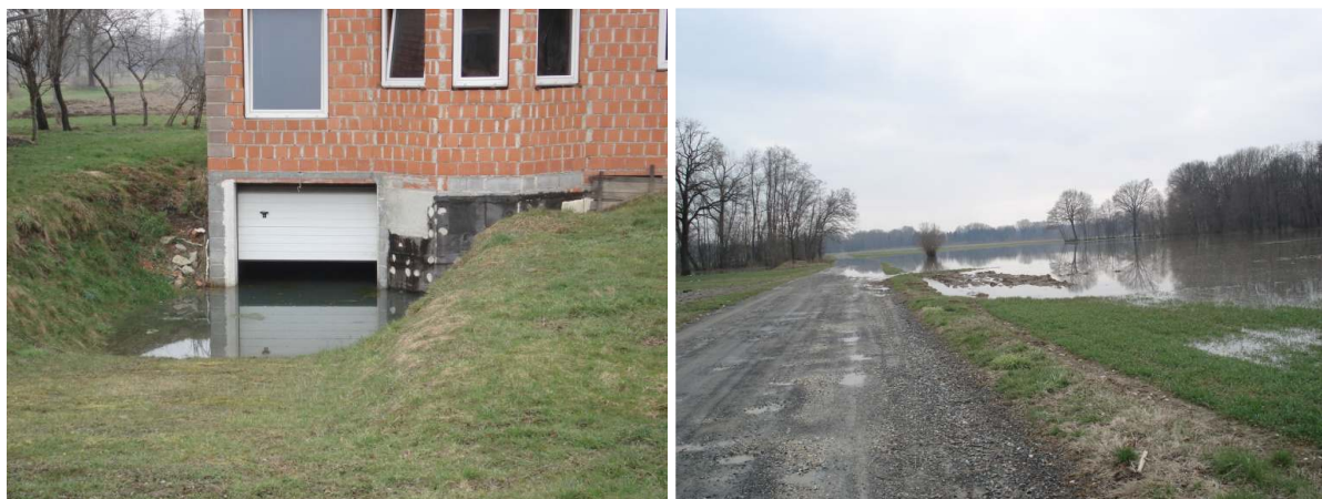
Slika 1. Zalita klet objekta v Apačah na Apaškem polju (levo) in preplavljeno cestišče na zahodnem robu Prekmurskega polja (desno)
