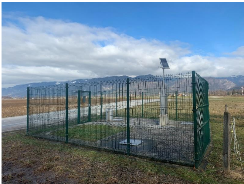
Slika 2. Objekt za spremljanje stanja podzemnih voda na območju Radovljice, februar 2021 Figure 2. Groundwater monitoring object in Radovljica, February 2021
