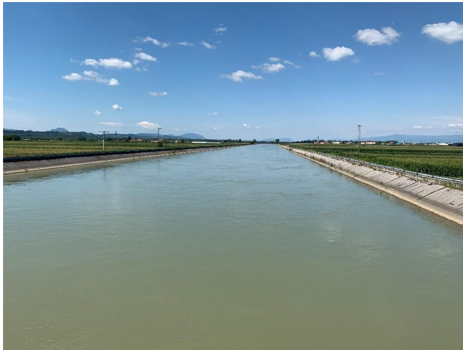
Slika 1. Odvodni kanal Formin v letu 2020, ki na večjem delu vodonosnika Ptujkega polja ne vpliva na podzemno vodo zaradi neprepustne betonske pregrade na obeh straneh kanala
